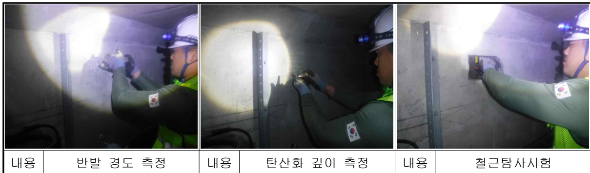
【사진 3.17】 진건분기 재료시험 전경
