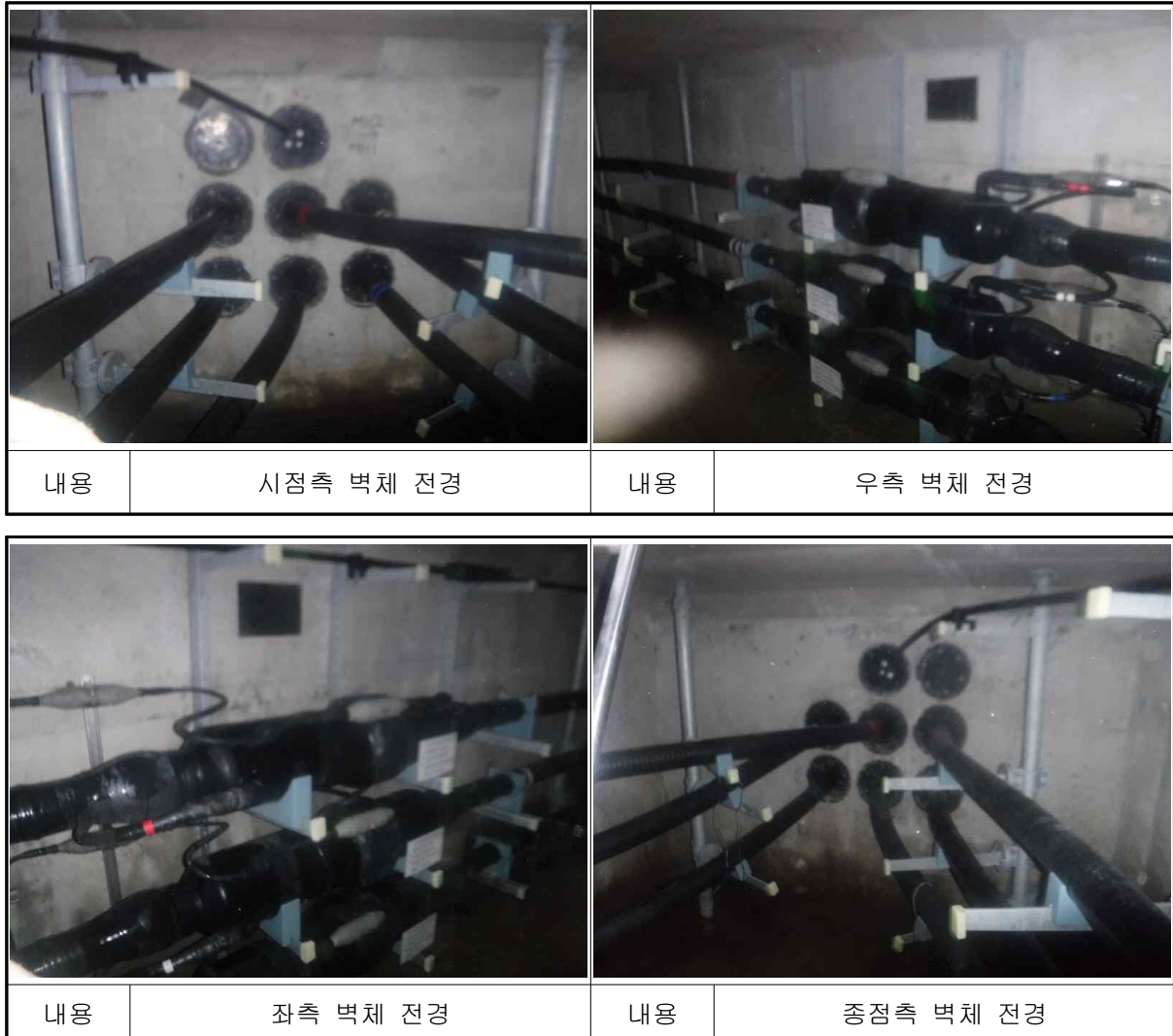
[사진 3.13] 진건~별내#2 전경
