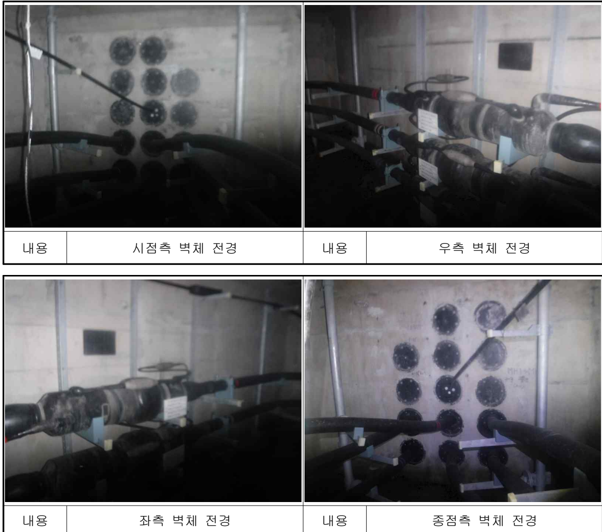
[사진 3.9] 진건~별내#1 전경
